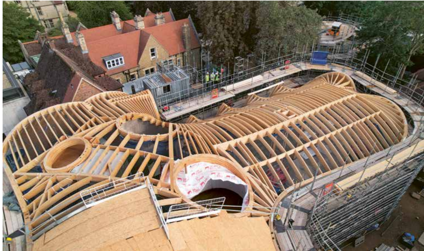
Die kreative Lösung für das Dach besteht aus einer Freiform mit tragender Holzstruktur und spart graue Energie.
