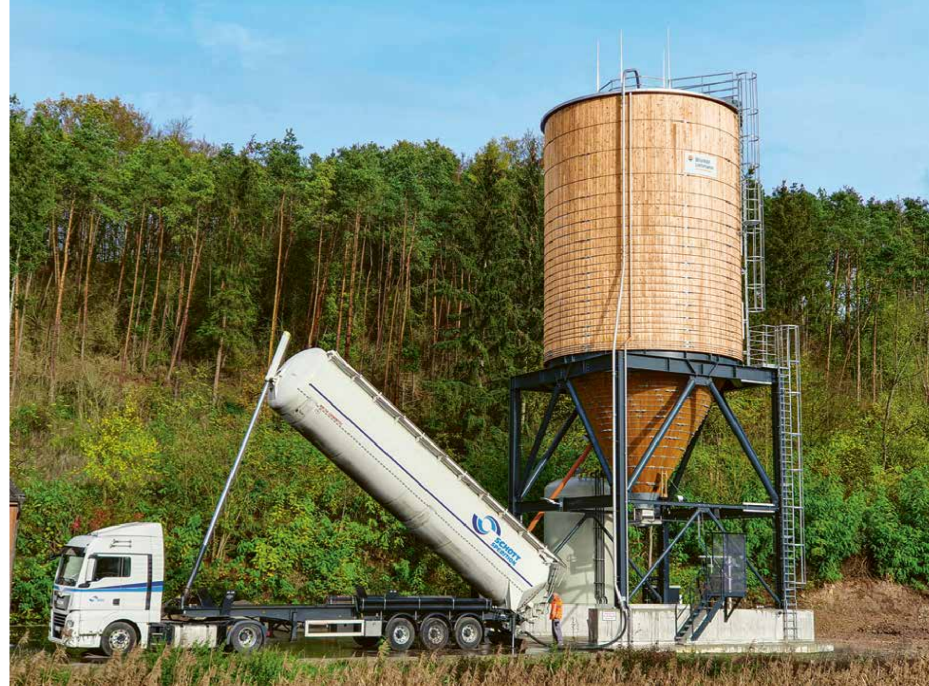
Befüllung des Silos mit Steinsalz über das Füllrohr.
