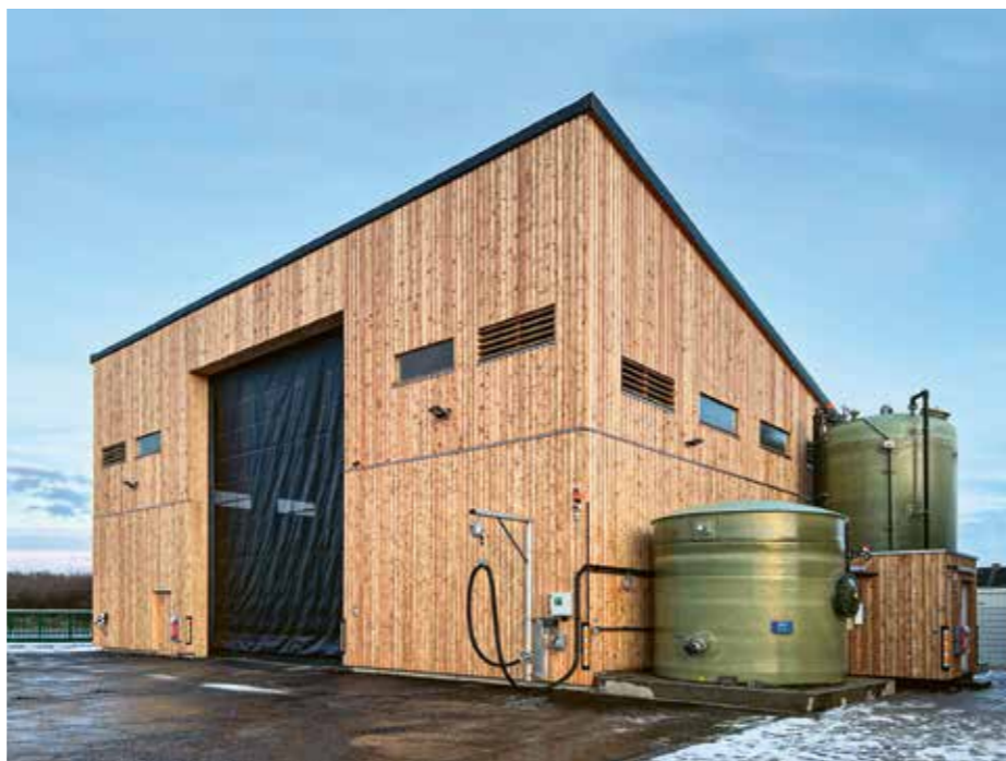
Salzlagerhalle für 600 m 3 Salz mit Soleanlage und Technikraum.
