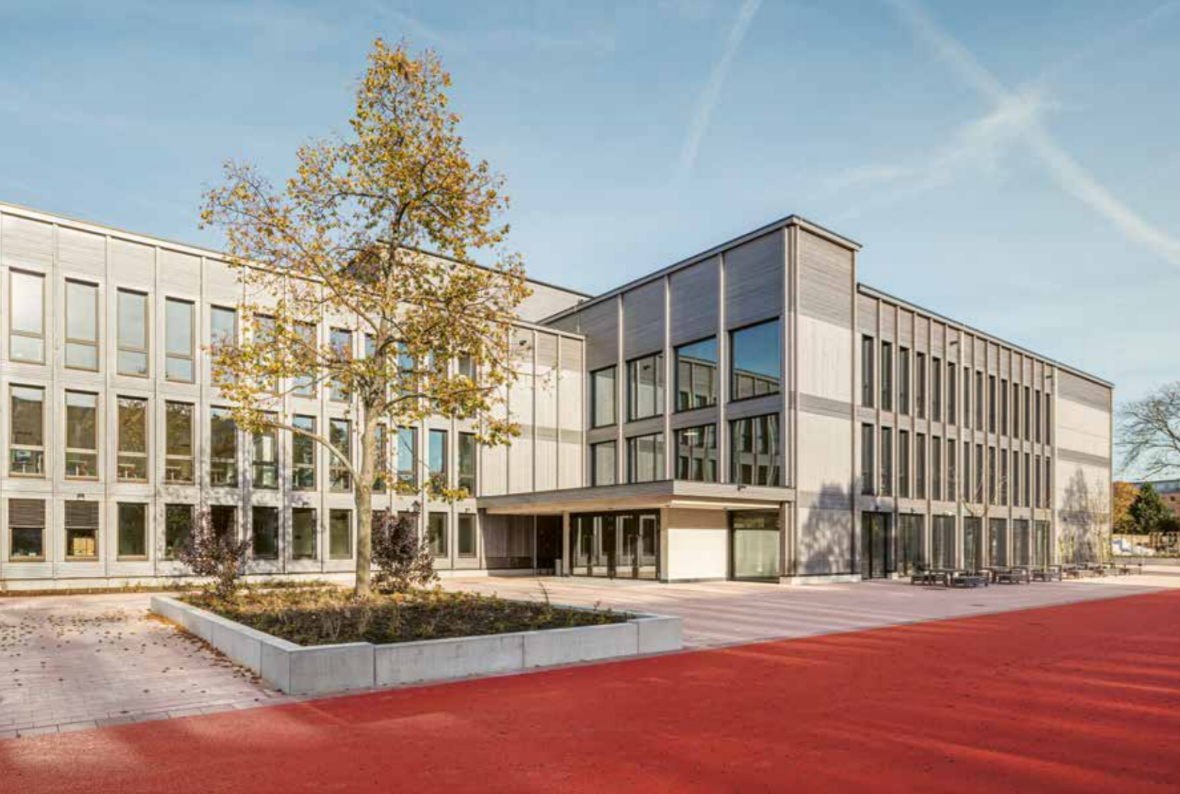
Das dreigeschossige Schulgebäude in hybrider Modul-/Elementbauweise aus Holz verfügt über 28 Klassenräume, eine Küche und eine Mensa.
