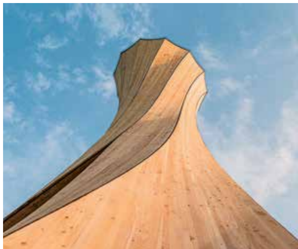
Bekannte Regel in neuer Anwendung: Wenn feuchtes Holz trocknet, zieht es sich senkrecht zur Faserrichtung stärker zusammen als parallel zur Faserrichtung. So brachte sich der Urbach-Turm beinahe selbst in die gewundene Form.
